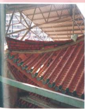
工匠正在砌上绿色滴水沟，以保有原貌、原色的滴水沟。
